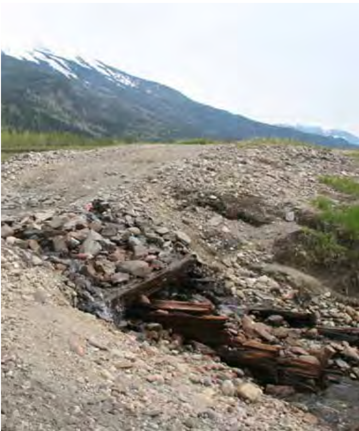
Cartier Box Culvert
