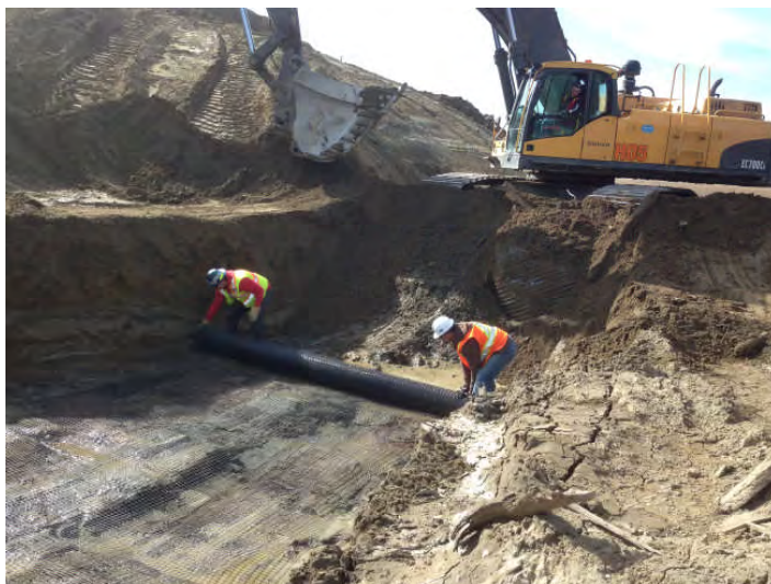
Rolling out Geo Grid
