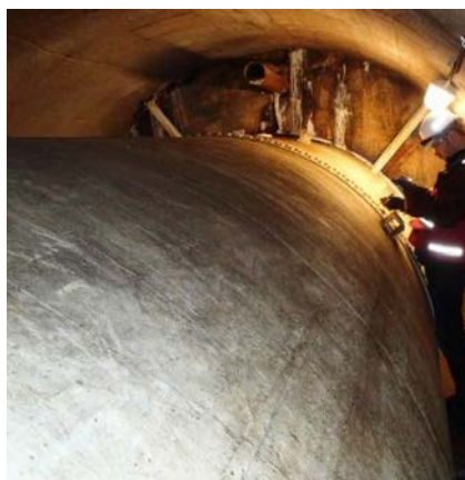
La Joie- South Conduit
